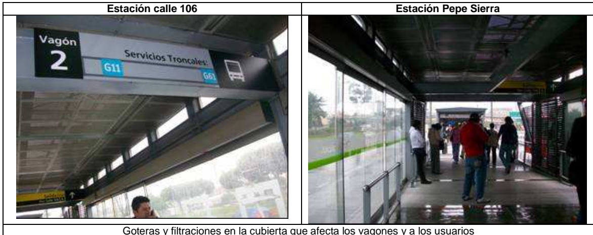
Goteras y filtraciones en la cubierta que afecta los vagones y a los usuarios
